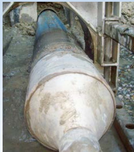
Ferdig utblokket og inntrukket nytt rør.
