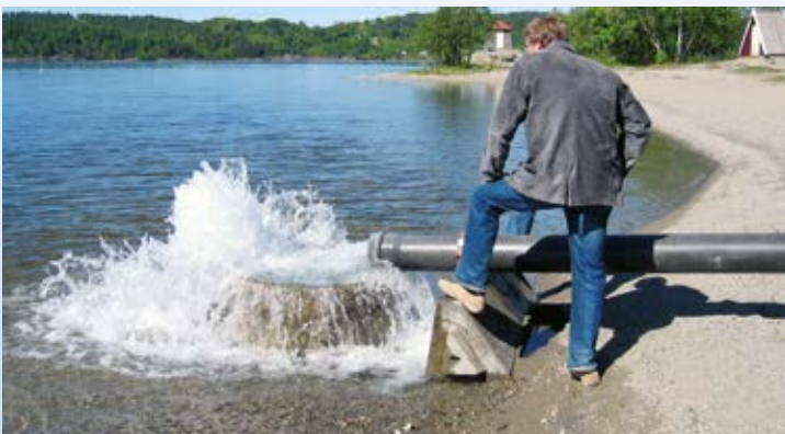
Testing av brønnen, kapasitet ca. 280 l/sek.
