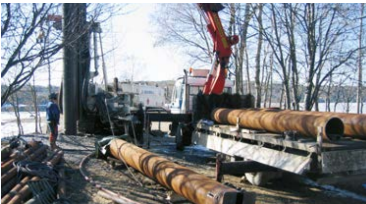
Utførelse av brønn i løsmasser, dia. \varnothing 500 mm.
