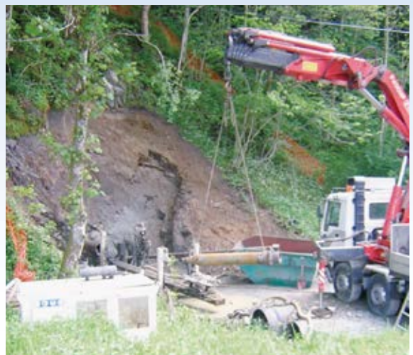
Ø400 mm hull á 300 meter i Bergen, våren 2005.
