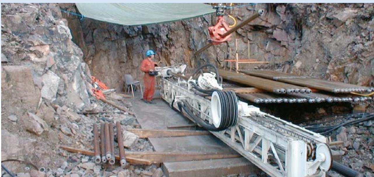
Boring av \varnothing 600 mm langt hull på Nesoddtangen.
