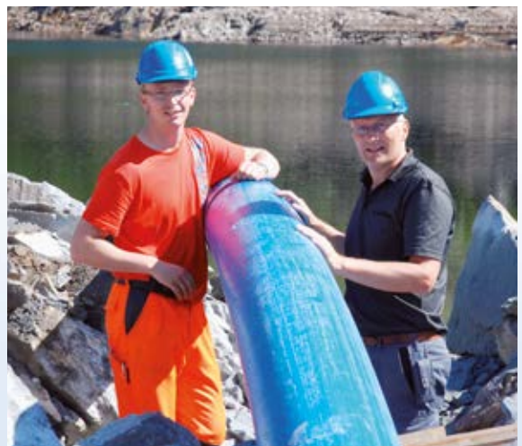
305 meter med Ø315mm PE 100 SDR 7,4 med PP-kappe som ferdig inntrukket i fjellhull med 52% fall.
