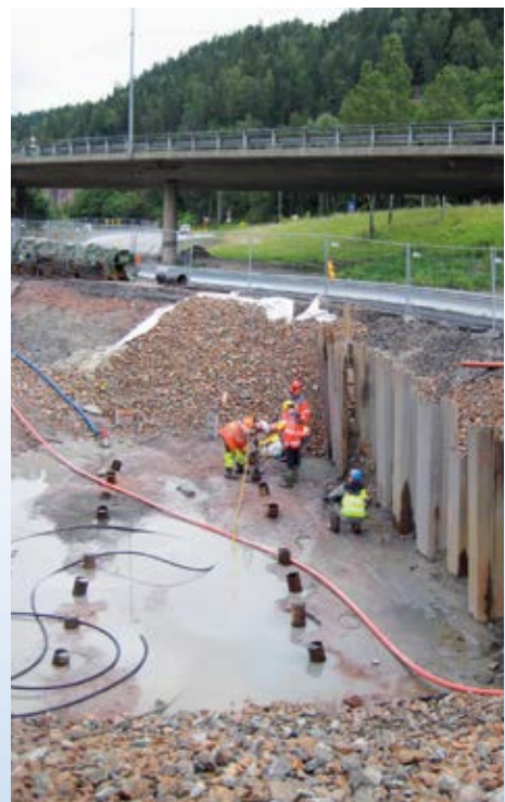
Ca. 2000 meter med borede stålrør og monterte Ø130mm stålkjernepeler. Ny 2-felt bru i Drammen (E-18 i Kobbervikdalen).
