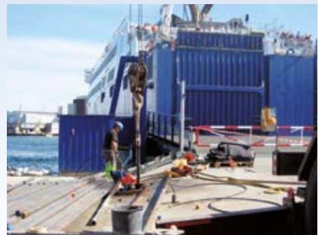
Ca. 2000 meter med borede stålrør og monterte Ø90mm og 120mm stålkjernepeler. Color Line terminalen i Kristiansand.
